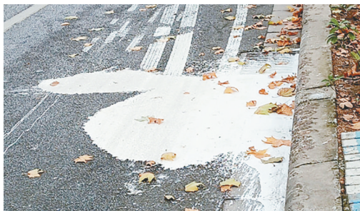
湘江西路与文化路交叉口向西约120米路南，路面不洁。
