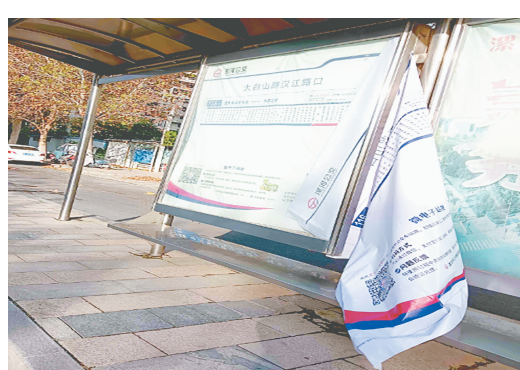
太白山路与汉江路交叉向北约70米路东,公交站亭线路图脱落。
