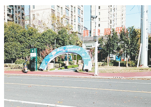
韶山路与湘江路交叉向北约30米路东,户外广告牌倾斜。
