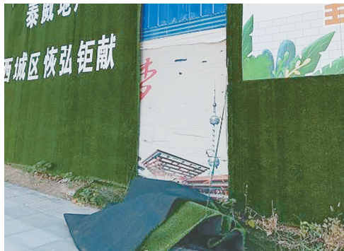
月湾湖东路与九龙山路交叉口向西约120米路南，围挡网破损。
