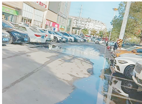
金江路与泰山南路交叉口向西约80米路北，下水道堵塞，污水外溢。
