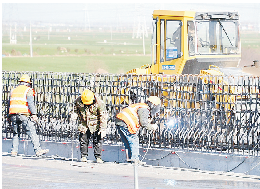
国道107漯河境新建工程防撞护栏钢筋安装现场。
