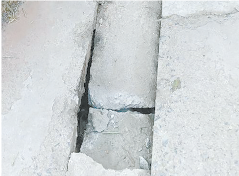
万庄南园街与解放南路交叉口向东约140米路南，污水盖板破损。
