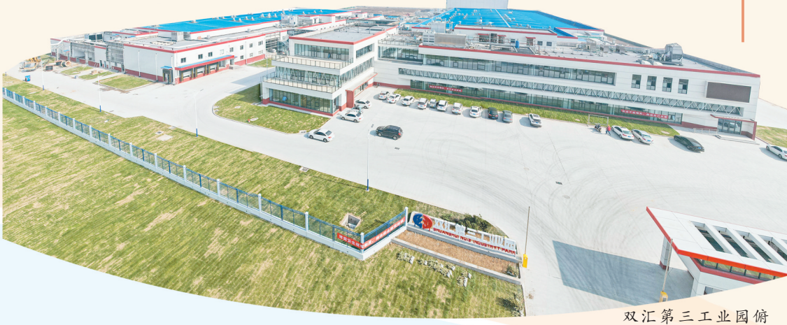
双汇第三工业园俯瞰图
