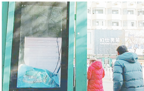
交通南路与马路街交叉口向北约30米路西,公交站亭橱窗内公益广告脱落。
