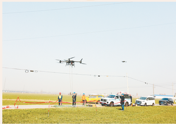
国网漯河供电公司工作人员利用无人机安装相间间隔棒,保障线路安全稳定运行。 本报记者 王嘉明 摄
