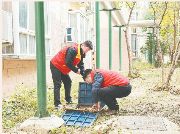
市清源供水有限公司检修人员在文萃江南小区为表井加盖草苫子。 本报记者 朱红 摄
