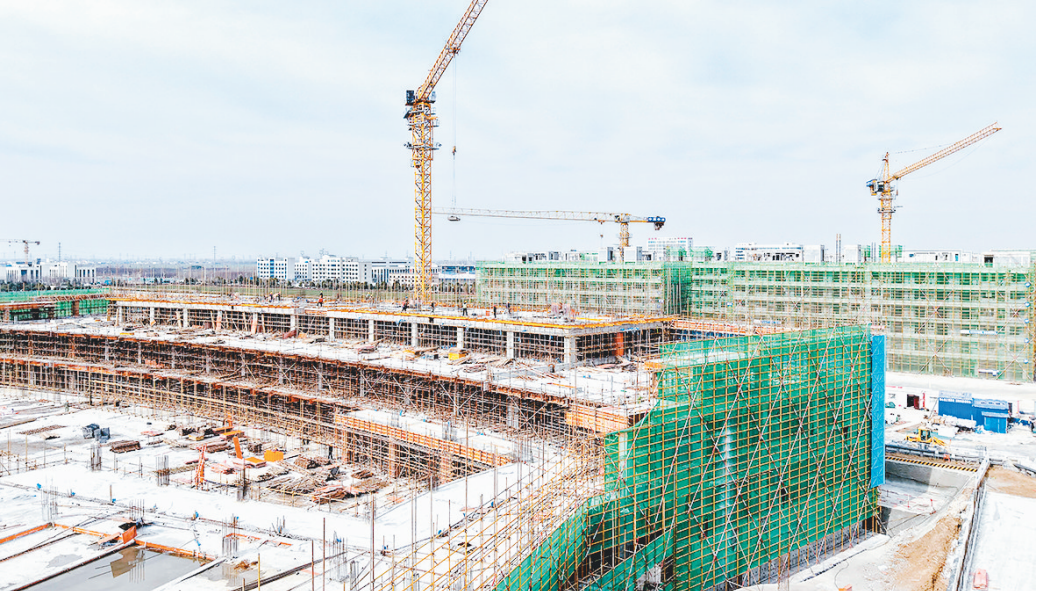
建设中的市养老产业综合服务园项目
