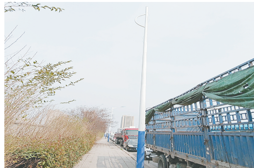
汇丰街与王屋山路交叉口向东约60米路北，路灯灯头缺失。
