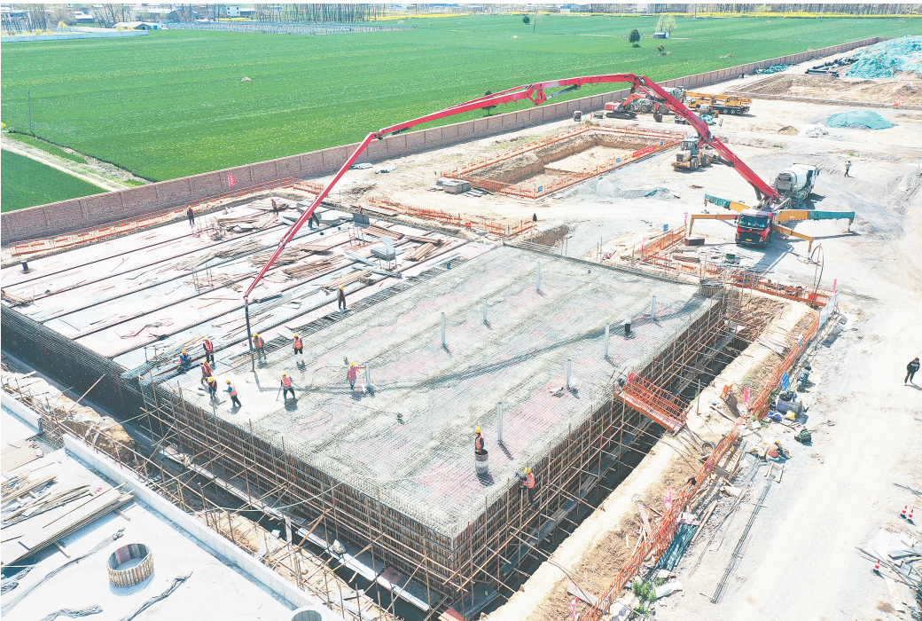
裴城水厂及配水管网项目工地，一派热火朝天的施工景象。
