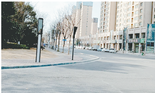
太白山路与芙蓉江路交叉口向南约2米路西，人行道上，交通信号灯缺失。
