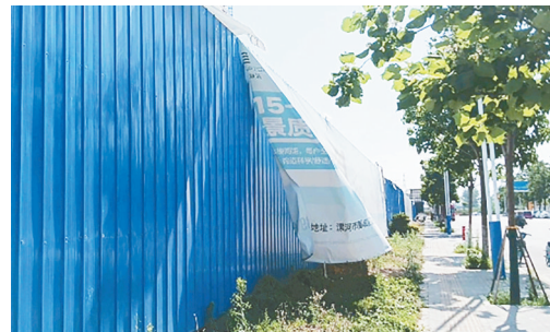
岷江路与交通北路交叉口向西约160米路北，建业中梁·新筑工地围挡上广告破损。
