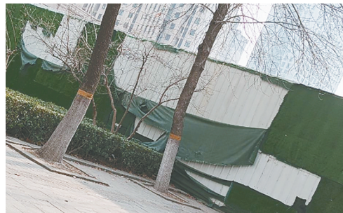
长江路与太白山路交叉口向东约50米路南，滨湖国际工地围挡上绿网破损。
