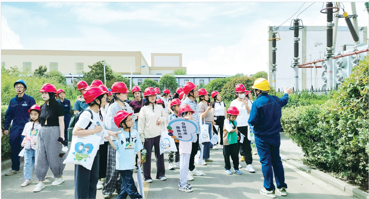
在升压站，工作人员向参观团介绍电力生产输送管控流程。
