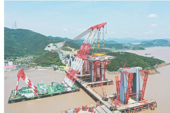
5月27日，在舟舟铁路西墩门公铁两用大桥建设现场，中铁大桥局“大桥海鹰”号起重船将节段钢梁吊装到指定位置。西墩门公铁两用大桥是舟舟铁路及舟舟高速公路跨越西墩门水道的共用跨海桥梁，连接舟山金塘岛和册子岛，是全线关键性控制工程。
