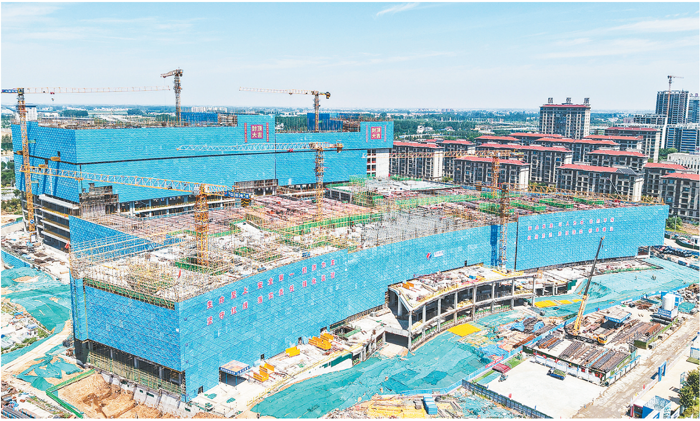
高水平医院项目建筑工地现场。
