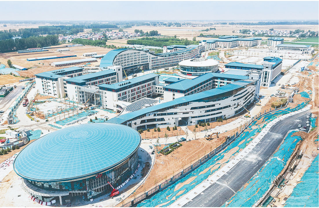
漯河高中新校区项目工地。
