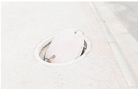
金山路与樟江路交叉口向北约150米路西,人行道上井盖沉陷。
