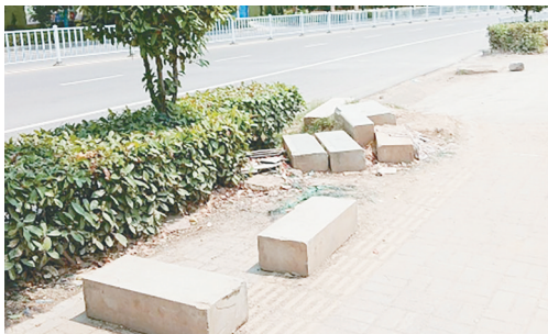
泾河路与九龙山路交叉口向东约140米路南,人行道上石块乱堆。
