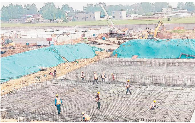
在裴城水厂施工现场,工人正在浇筑沉淀池绑扎钢筋。
