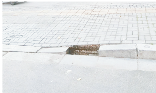
乐山路与长江路交叉口向南约30米路东,道边石缺失。
