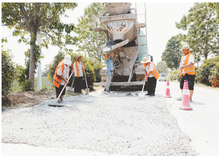
道路养护工人抢修破损路面。
