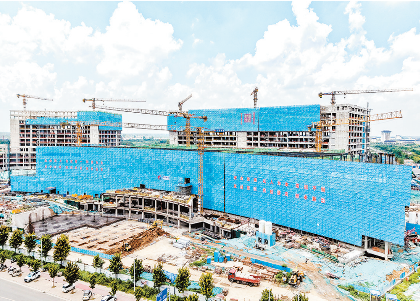
高水平医院建设项目主体结构已封顶,工人们正在进行附属设施建设(7月24日摄)。
