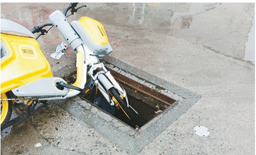
桂江路与白云山南路交叉口向东约160米路南，井盖缺失。
