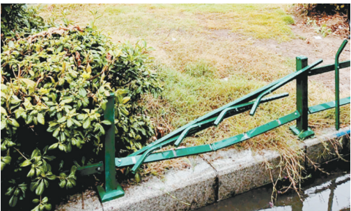
辽河路与太白山北路交叉口向东约80米路北，绿地护栏损坏。
