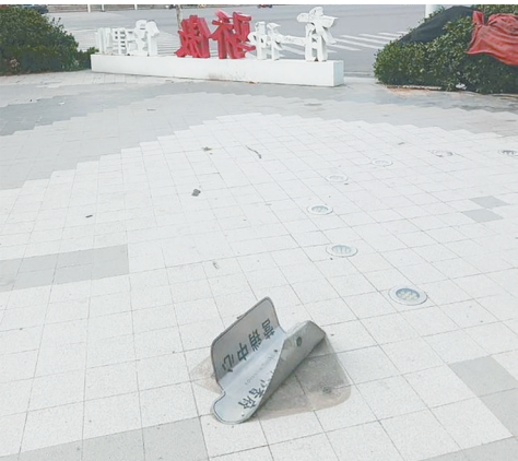
解放北路与龙江西路交叉口向南约10米路西，地面上龙湖书香府指示牌破损、翘起。
