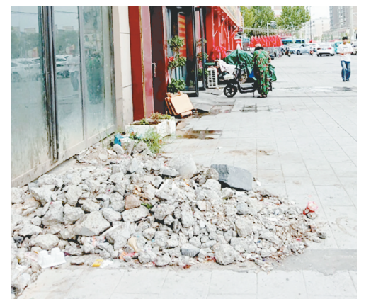
岷江路与井冈山北路交叉口向东约80米路南,门面房前积存渣土未及时清理。
