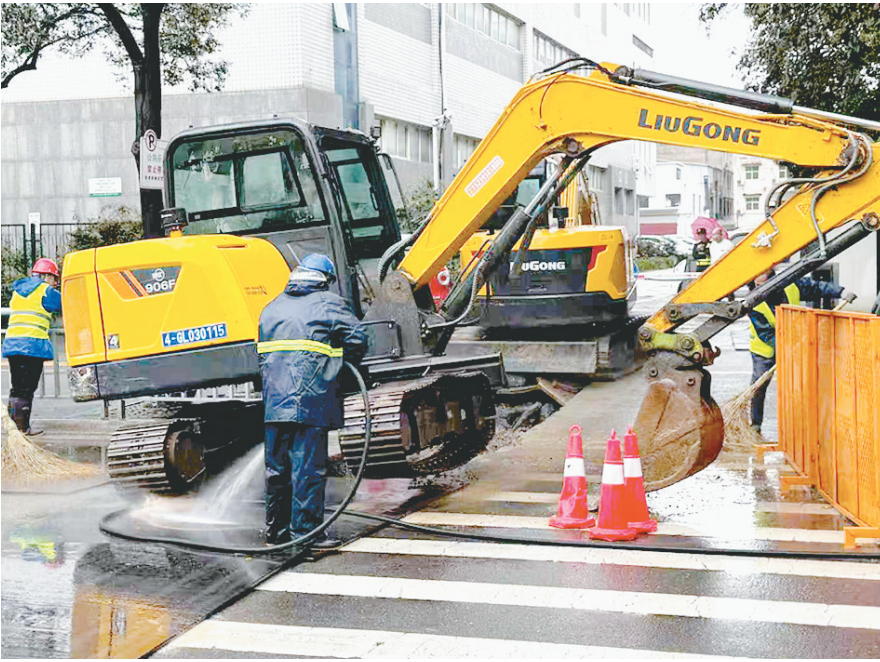
“汽改水”工程施工现场
