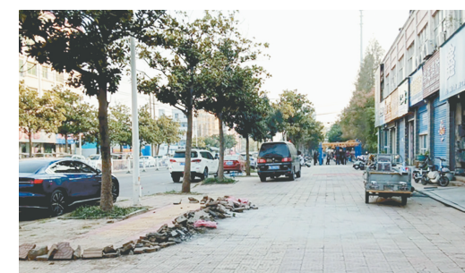
五一路与金江路交叉口向北约90米路西，维修人行道地砖完工后废弃地砖未及时清理。
