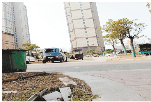
丹山路与漓江路交叉口向南约100米路西,六和世家小区西区28号楼西侧,路边井盖缺失。
