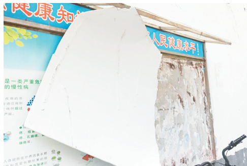
中华街与交通南路交叉口向东约120米路北，宣传展板破损。
