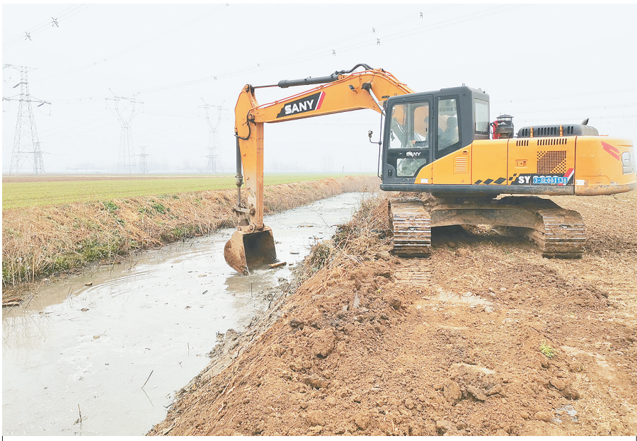
12月23日，在召陵区召陵镇农田，一台挖掘机正在清理沟渠里的淤泥和杂物，确保排水畅通。
