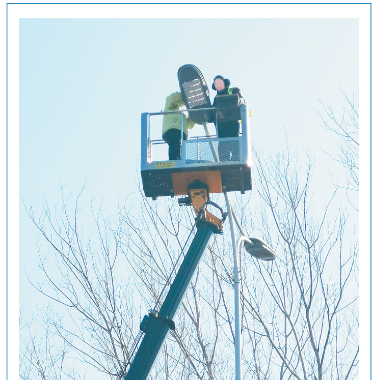
1月7日,市路灯维护中心工作人员冒着严寒在金山路维修路灯。连日来,市路灯维护中心对全市主次干道路灯亮灯情况进行全面排查,并对发现的安全隐患及故障进行及时处理。
