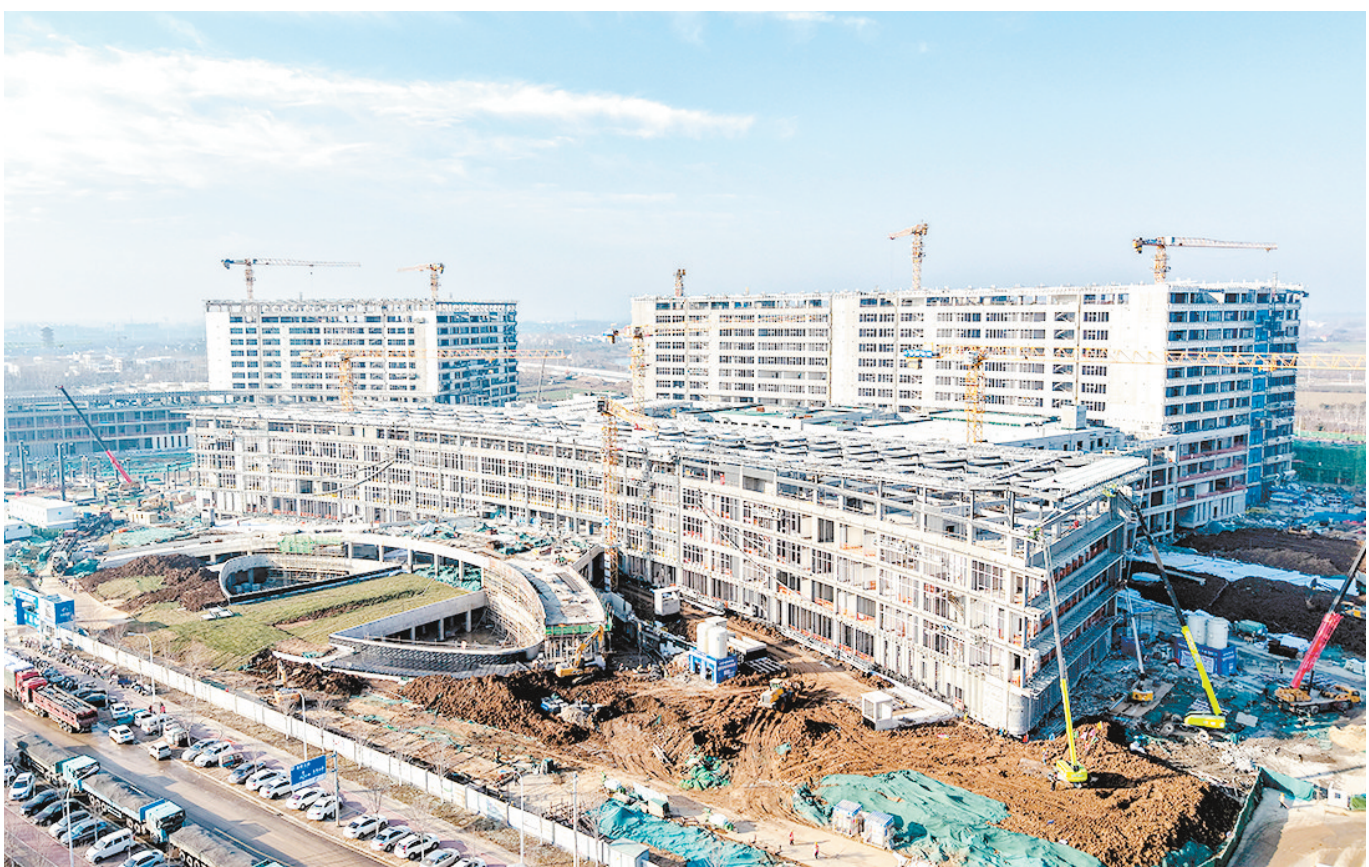
工人们干劲十足，外墙窗框的安装声与机电安装的调试声相互交织……1月10日，市高水平医院项目建设现场一派繁忙景象。
