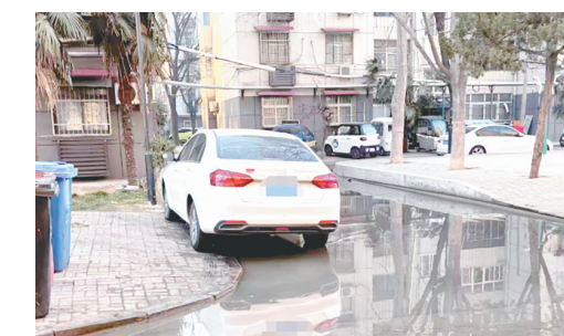
泰山路与支一路交叉口新大新商场南，路面污水横流。
