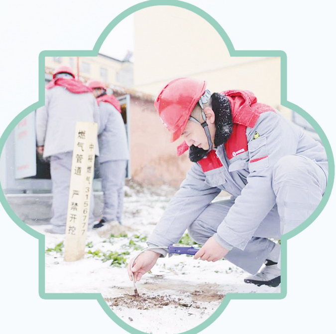
工作人员在松江美食街附近，对燃气设备进行安全隐患排查。 本报记者 朱红 摄
