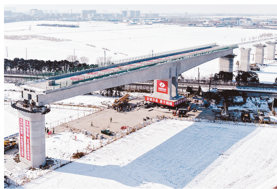
1月22日上午,平漯周高铁深商特大桥T字形结构转体梁在京广铁路上空平稳“转身”。
