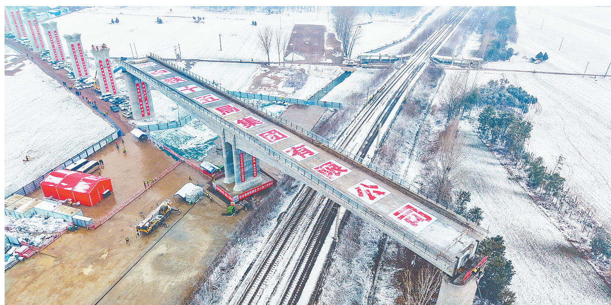
站前一月三十日,由中铁十五局集团承建的平漯周高铁站前五标漯商特大桥跨孟宝铁路转体梁成功转体。本报记者 李博 摄
