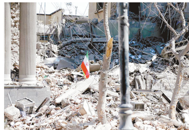
这是2026年3月4日在伊朗德黑兰革命广场附近拍摄的一处损毁的建筑。 新华社记者 沙达提 摄
