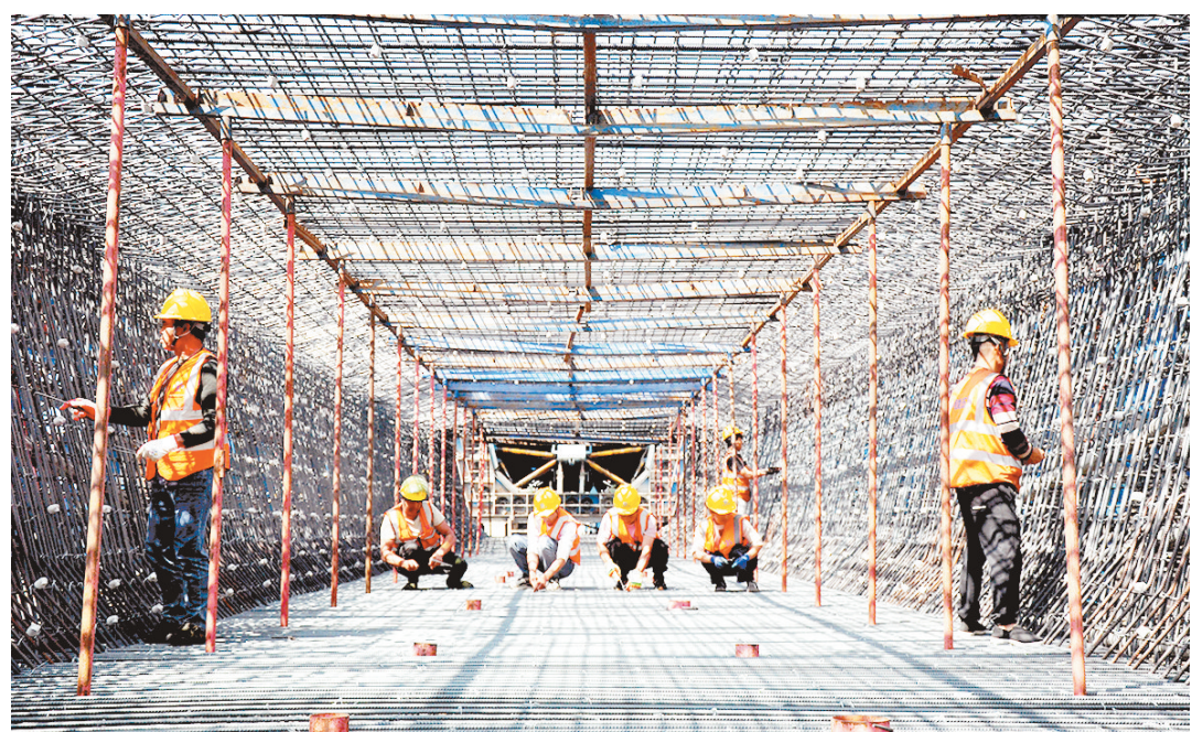
工人正在绑扎高铁箱梁钢筋笼。
