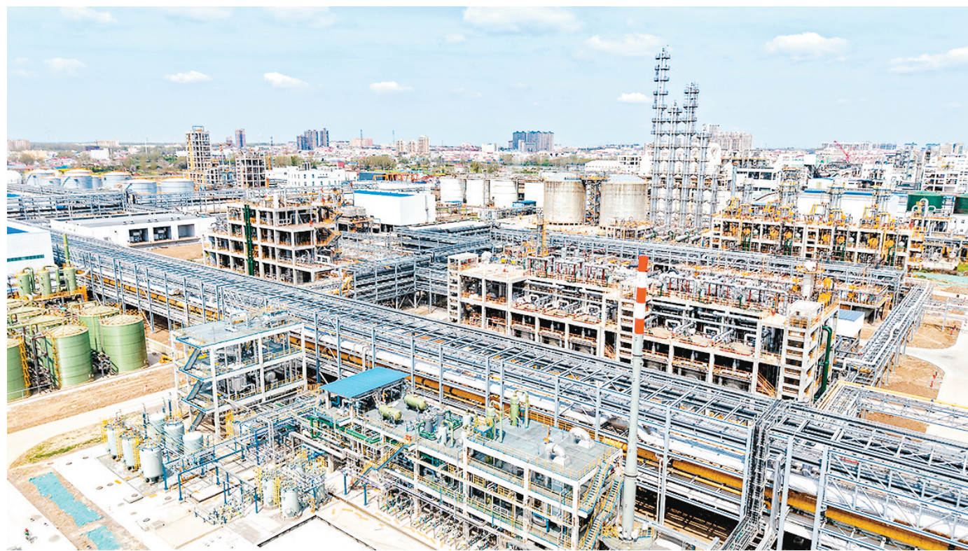
舞阳县金海氟硅新材料项目现场。
