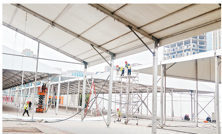
第二十三届中国（漯河）食品博览会临近，各项筹备工作有序进行。4月12日，记者在漯河国际会展中心主会场看到，施工人员在抢抓工期搭建场馆、布置展位。 本报记者 姚肖 摄
