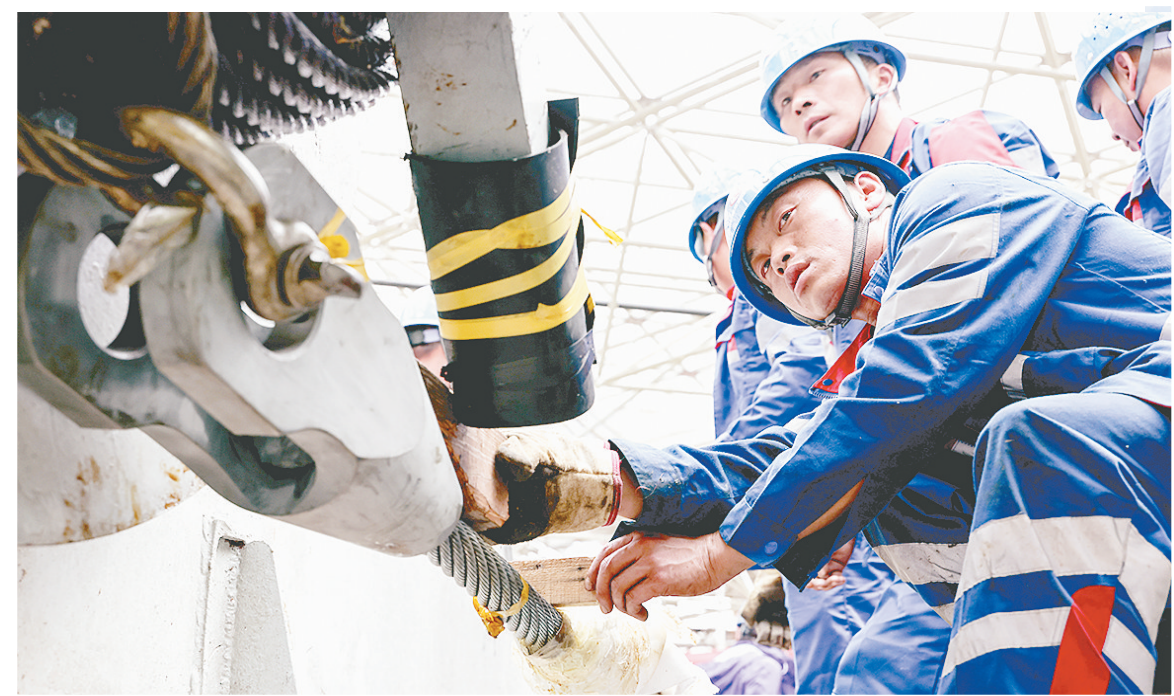
5月6日，工作人员更换馈源舱的锚固接头。
