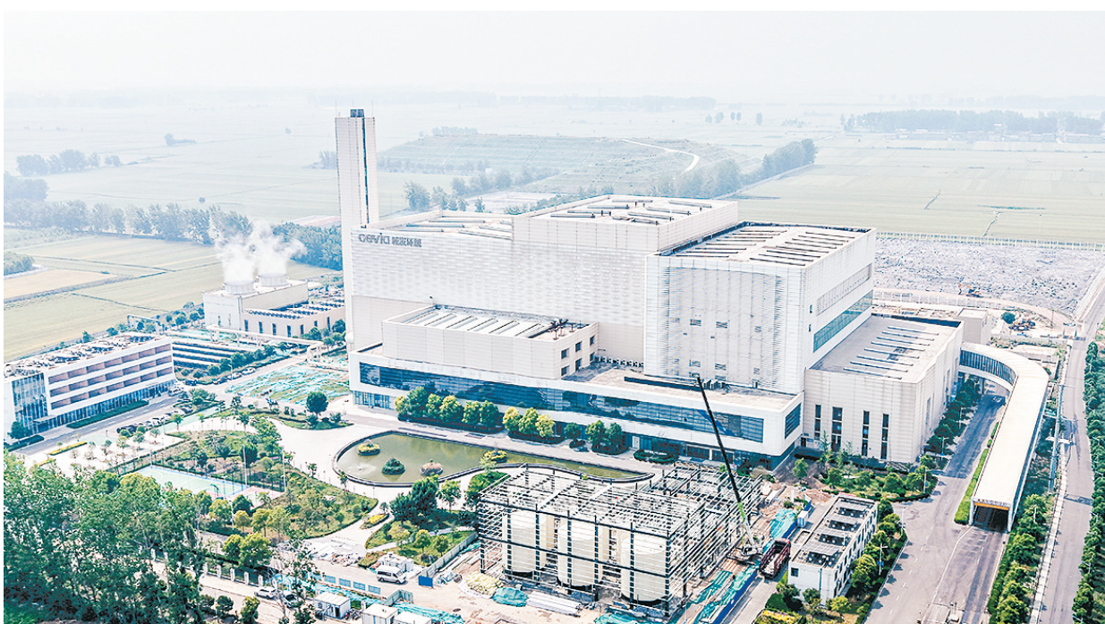
漯河城发环保能源有限公司厂区。
