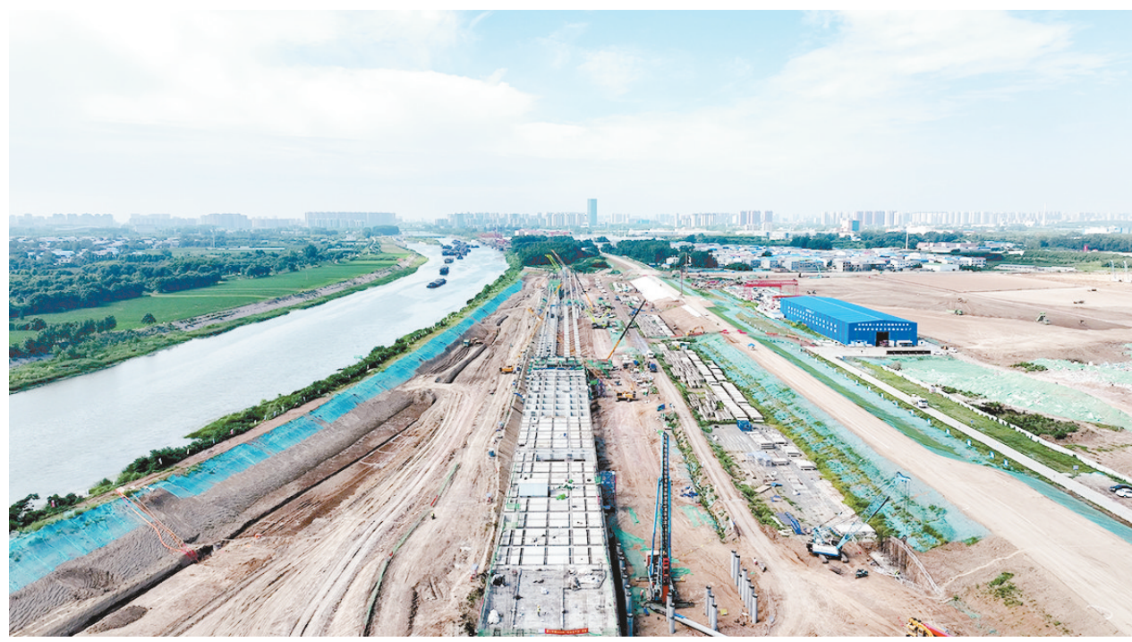
漯河港扩容提升工程建设现场。
