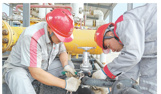
维护调压设备
