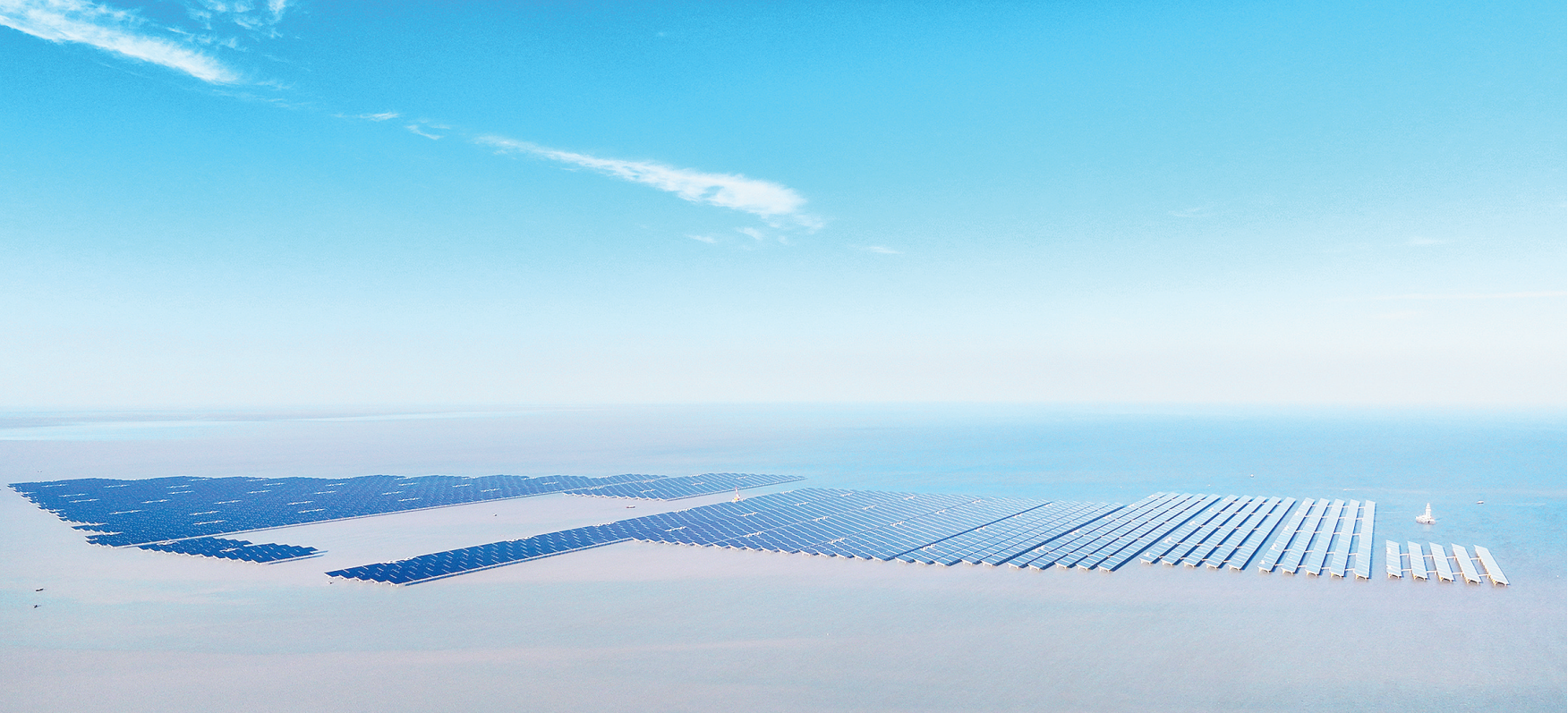
5月29日拍摄的位于山东省东营市的吉瓦级桩基固定式海上光伏项目——国华HG14海上光伏项目（无人机照片）。
