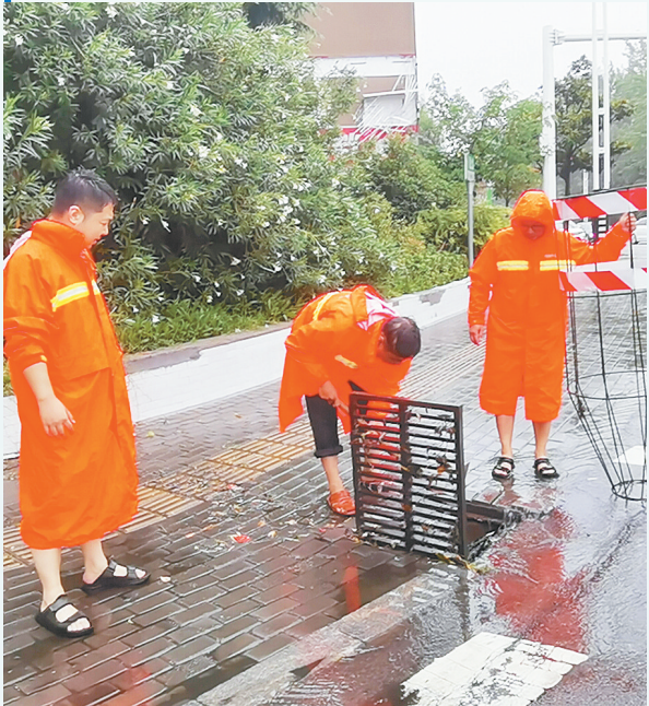
8月11日，市政工人在淞江路与解放路交叉口清理雨水篦子上的淤泥、杂物。 本报记者 范子恒 摄
