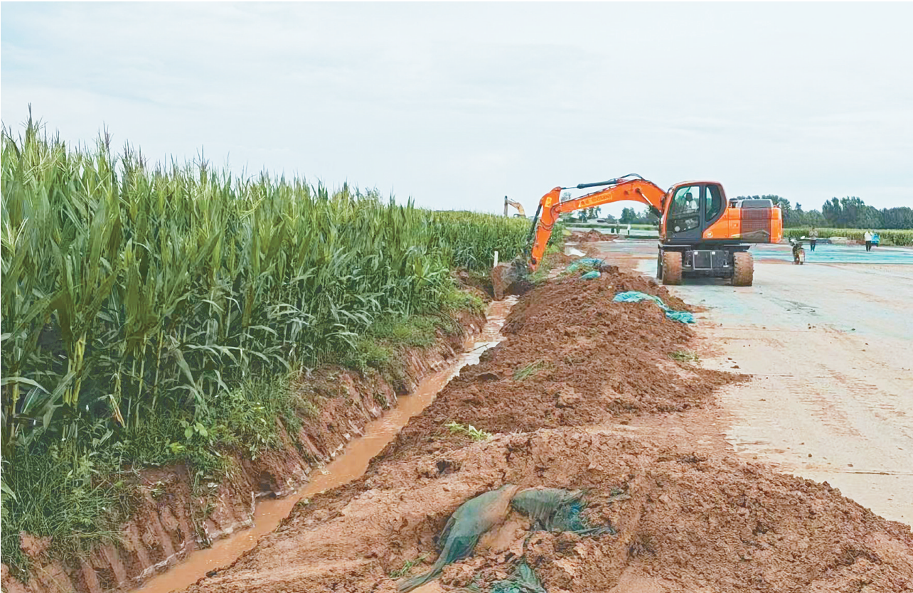
8月11日，间十乡调用挖掘机疏通田间排水沟渠，加快田间积水外排，以降低灾害对农作物造成的影响。
