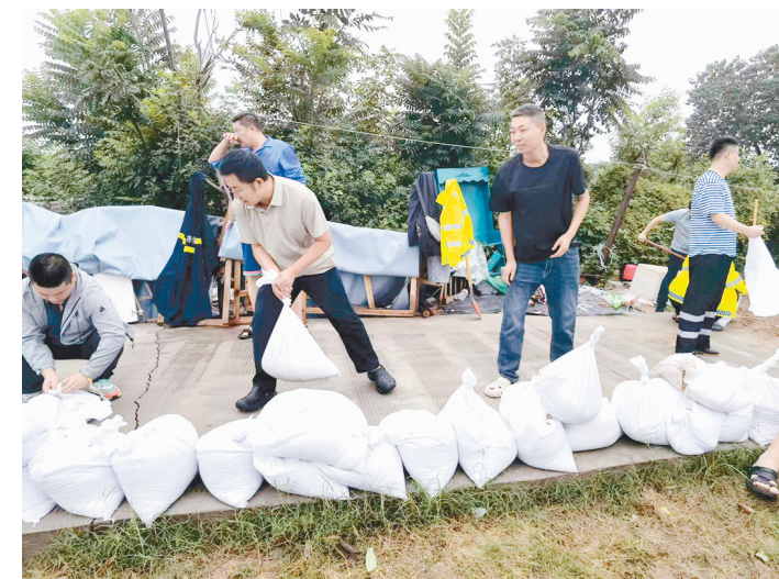
城管人员在用沙袋筑堤。
