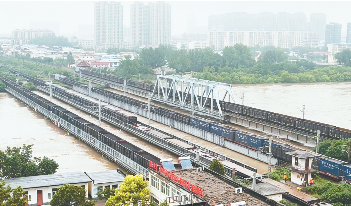
“重车压梁”现场。
