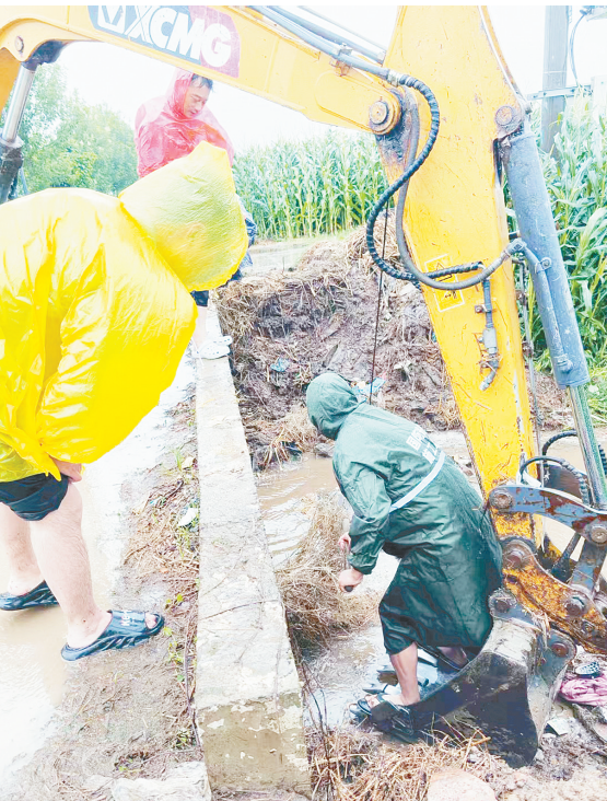
8月12日，郾城区孟庙镇组织村干部对田间沟渠开展清淤疏通。
