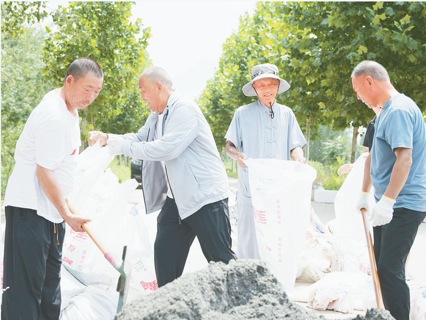
8月17日，在莲花镇泥河大桥，该镇党员干部装填防汛沙袋，运至堤防薄弱段，加高河堤、加固河道边坡。 本报记者 李宜书 摄
